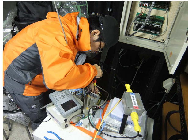
図5 避雷器の交換作業
