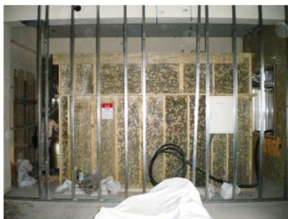
図 4 ECA700 仮囲い外観
