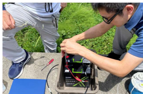
▲ 地震観測点設置の様子
