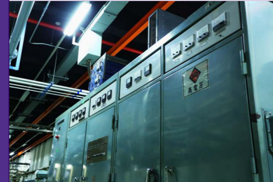
▲ (上)大強度電子線形加速器、(左下)大強度電子線形加速器の高周波電源、(右下)RI製造を行っている第一実験室。写真中央のコンクリート遮蔽体の中にRI製造装置が設置されている。
