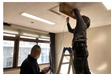
▲換気装置風速測定の様子
