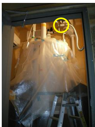
図4 従来の逆止弁の位置
