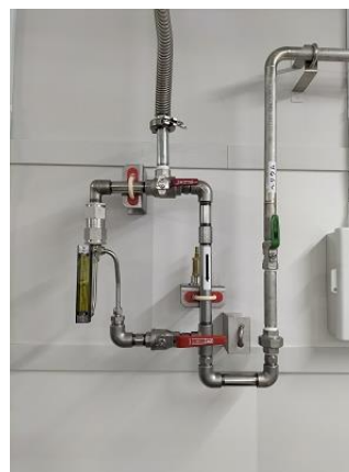
図5 新規増設した切り替えライン
